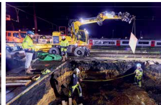
Travaux de consolidation des fondations.
