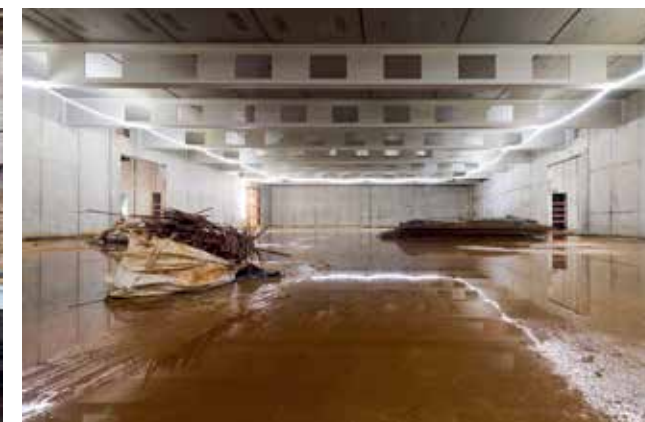
Espace intérieur brut en cours de transformation.
