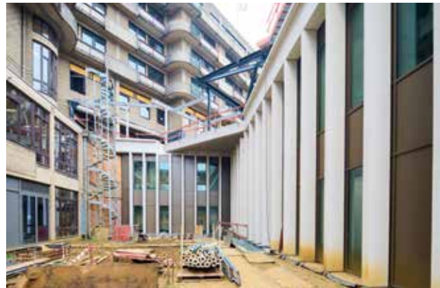
Travaux d'agrandissement au cœur du bâtiment.
