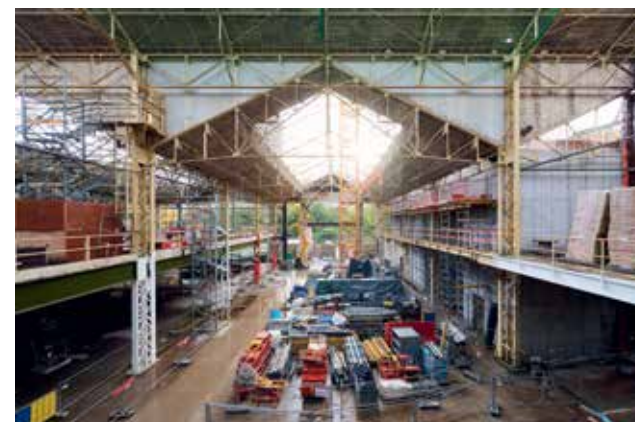
Logistique soignée pour coordonner plusieurs zones de travaux simultanées.
