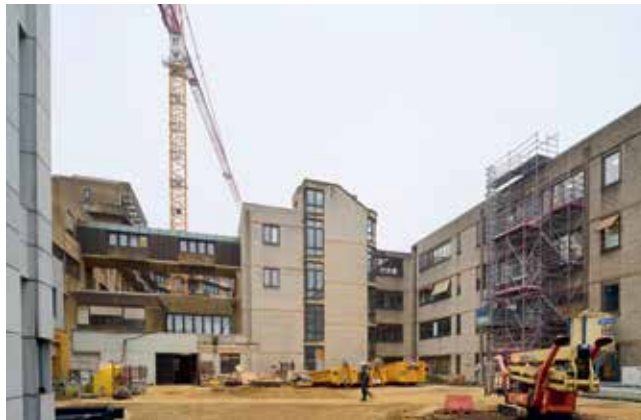
Chantier en cours sur une aile de l'hôpital.
