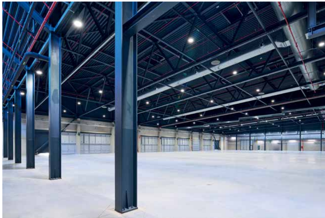
400 000 kilos d'acier pour une structure d'exception.
