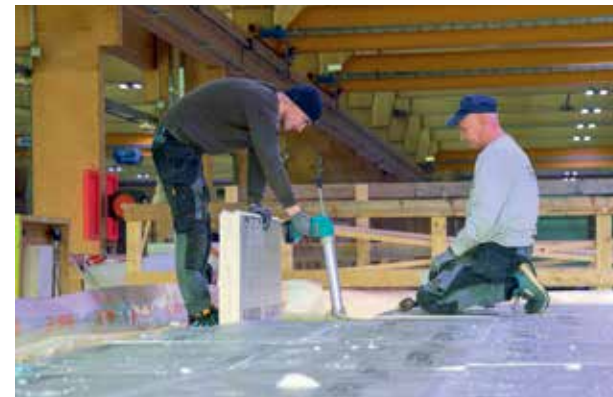
Isolation de la toiture.
