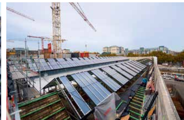
Installation d'éléments de toiture dans le respect de l'architecture d'origine.
