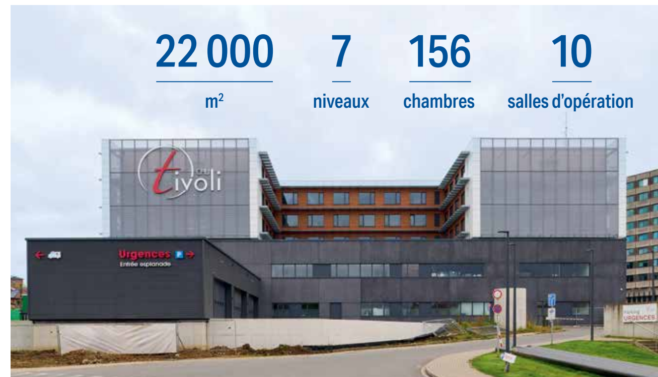
L'extension achevée du CHU Tivoli, ajoutant 156 nouvelles chambres et des infrastructures modernes dédiées aux urgences et aux blocs opératoires.
