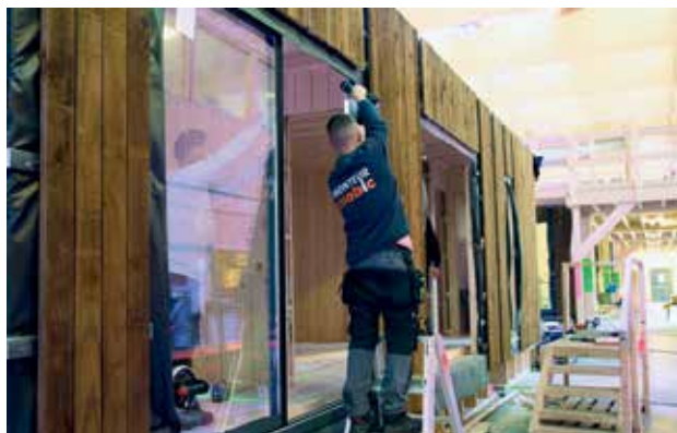
Montage des murs et de la toiture (3/3).
