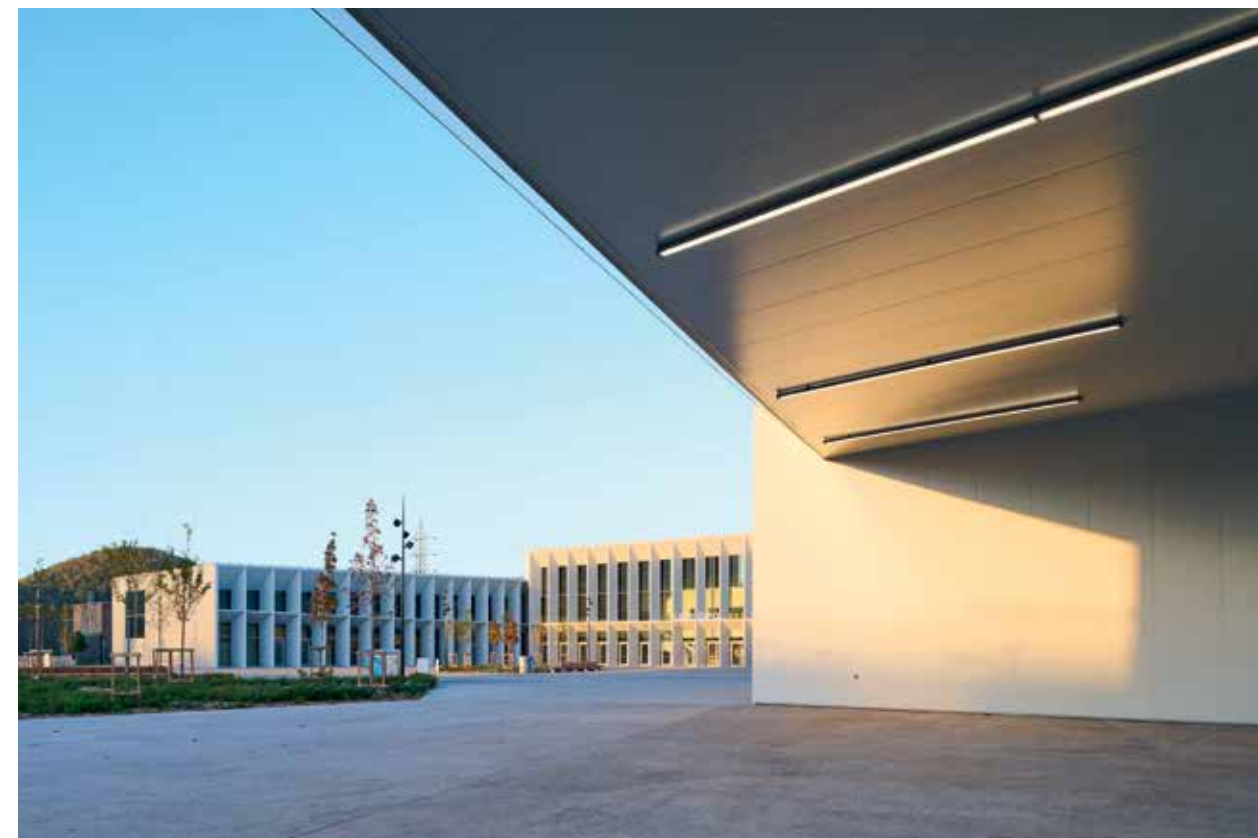
Vue extérieure des nouvelles infrastructures destinées à accueillir les grands événements de la ville.
