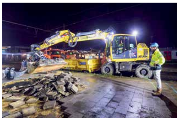
Déblayage des pavés et préparation du terrain.
