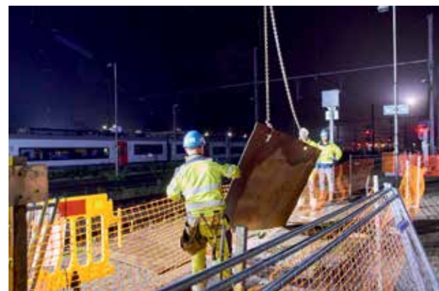
Travaux de levage pendant la nuit.
