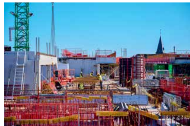
Un chantier colossal, en association avec Galère, Dherte et Denys.
