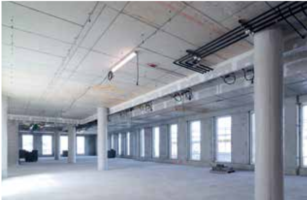
Un bâtiment de 14 étages en plein cœur de Charleroi.
