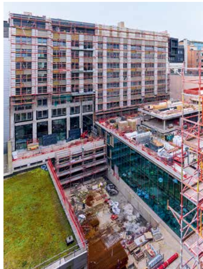
Un chantier de 37 000 m 2 en plein centre-ville.
