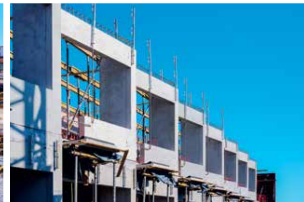
Le dépôt a fourni 385 cadres de façade préfabriqués.
