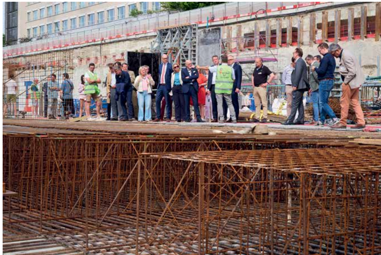
Les visiteurs ont découvert le chantier de l'UZ Gent, avec la construction du parking souterrain.
