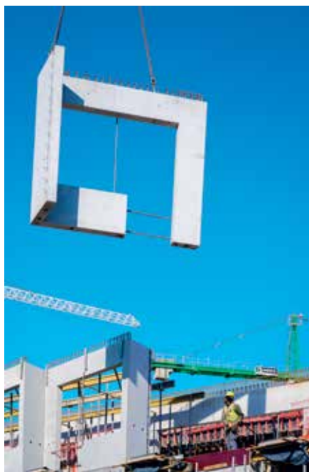
La préfabrication joue un rôle clé dans ce chantier.
