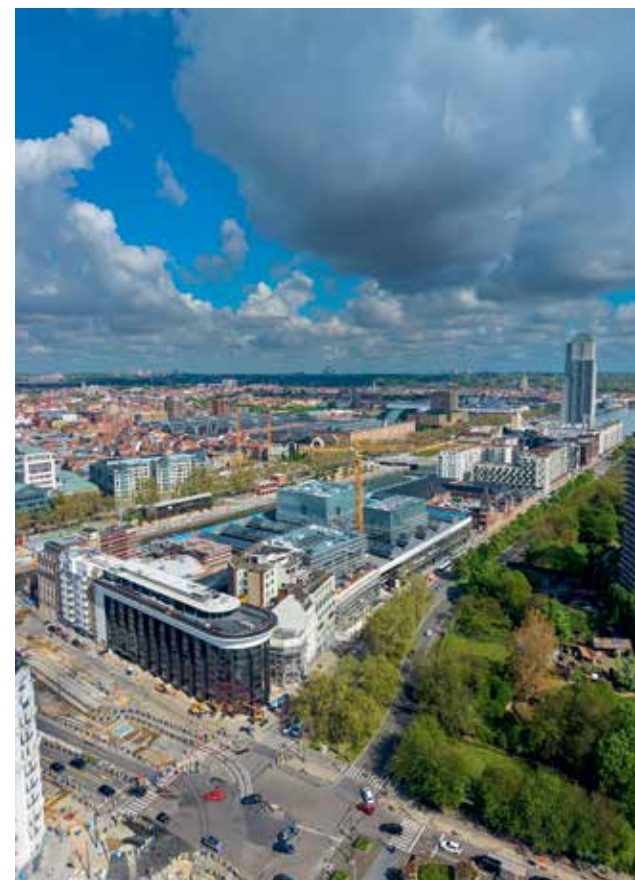
Un chantier aussi colossal que symbolique.
