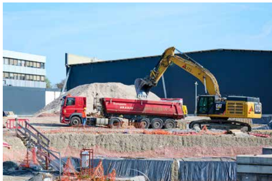
Les terrassements se poursuivent sur le site de Botanica.
