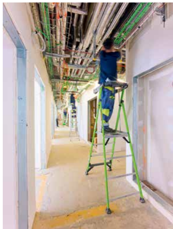
L'hôpital reste fonctionnel durant les travaux.
