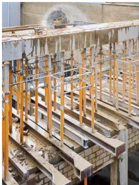
Une poutre en béton découpée avec une scie de 1,5 m de diamètre.
