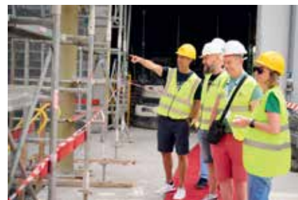
Les coulisses du chantier du CRP Les Marronniers.
