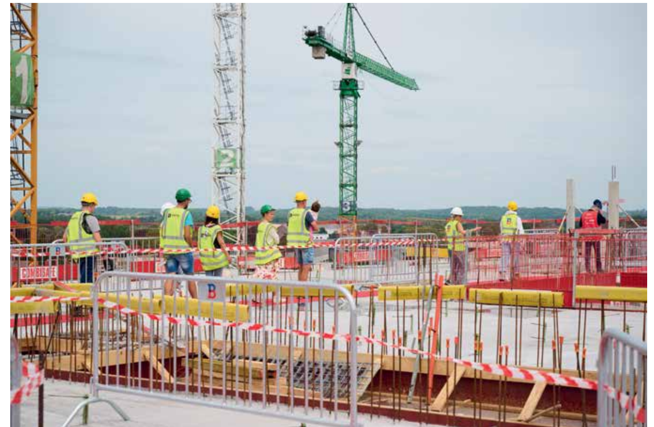
Les visiteurs ont pu monter au dernier étage du chantier du CRP Les Marronniers.
