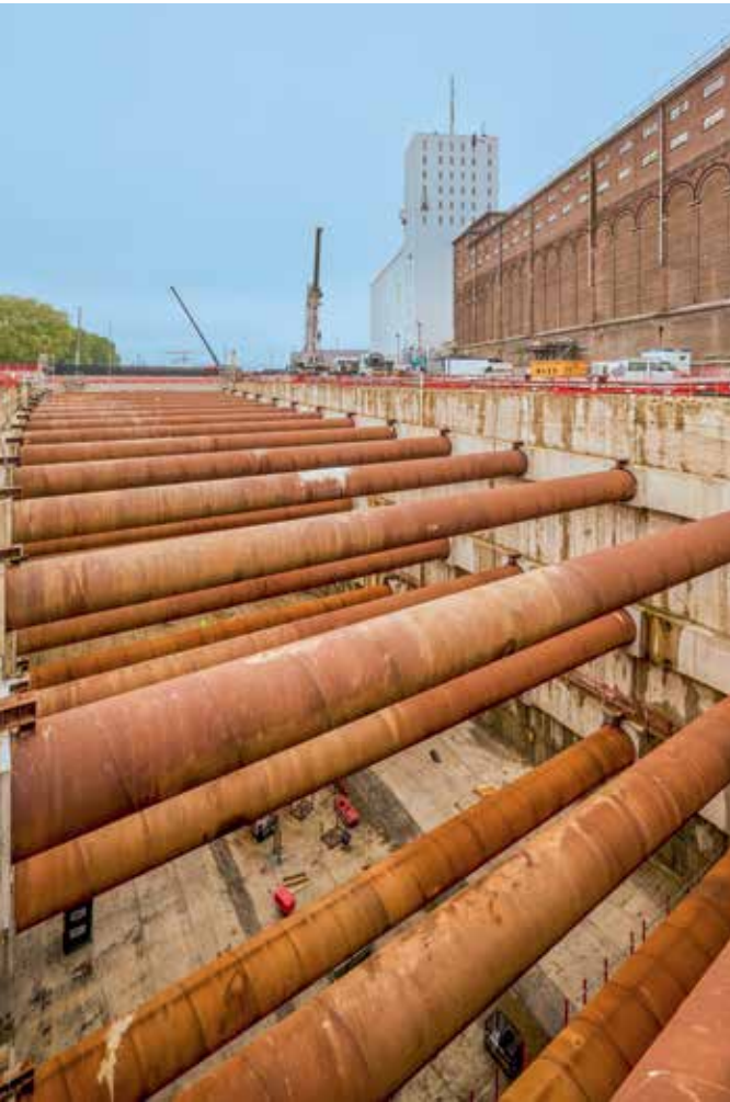
Un chantier titanesque à tous points de vue.
