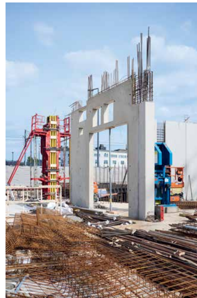
La préfabrication : une aide précieuse sur ce chantier.
