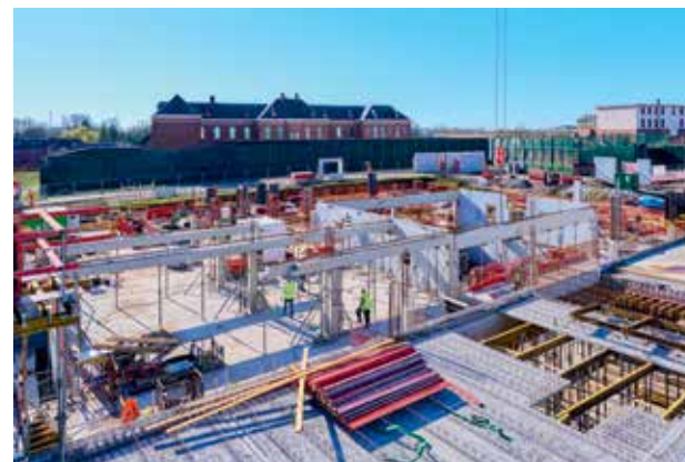
Un hôpital sécurisé de 40 500 m 2 répartis sur trois bâtiments.
