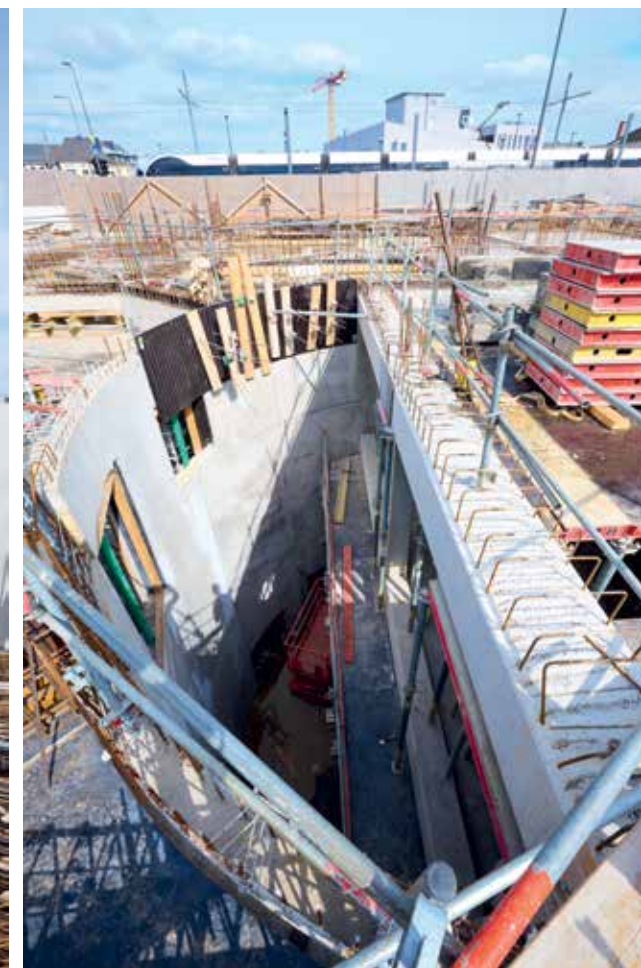
Le nouveau bâtiment administratif s'élève peu à peu.
