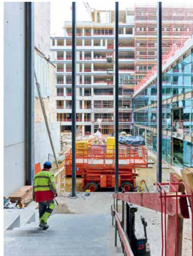
La logistique est l'un des grands défis de ce chantier.
